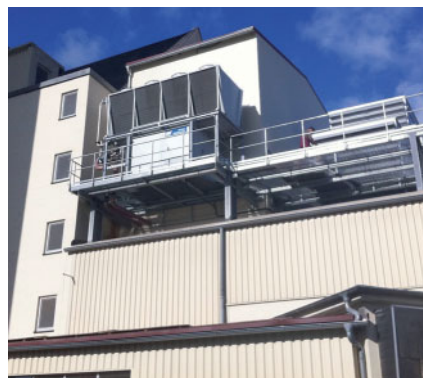
Der Kaltwassersatz mit Verflüssiger und Freier Kühlung wurde in zehn Metern Höhe aufgestellt Bilder: Frigoteam
